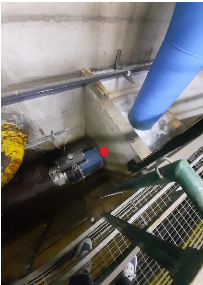
Foto 9 – Sifone bombato da smantellare e ricostruire compresa tubazione inghisata (punto rosso)
