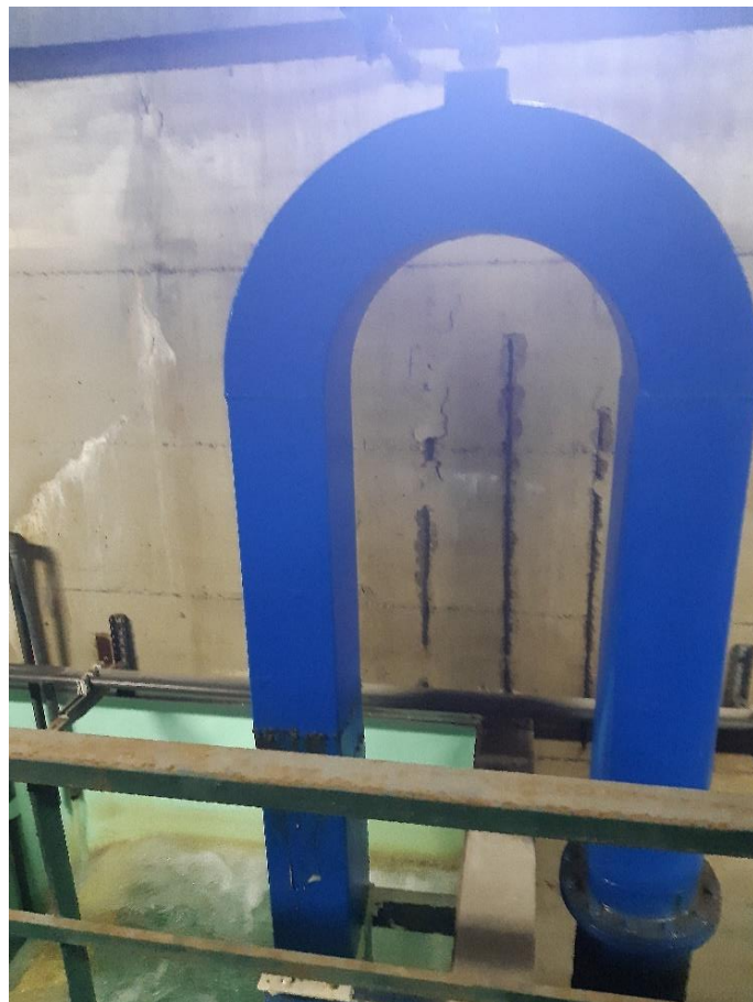
Foto 10 – Sifone a U da smantellare e ricostruire compresa tubazione inghisata con un sifone del modello bombato
