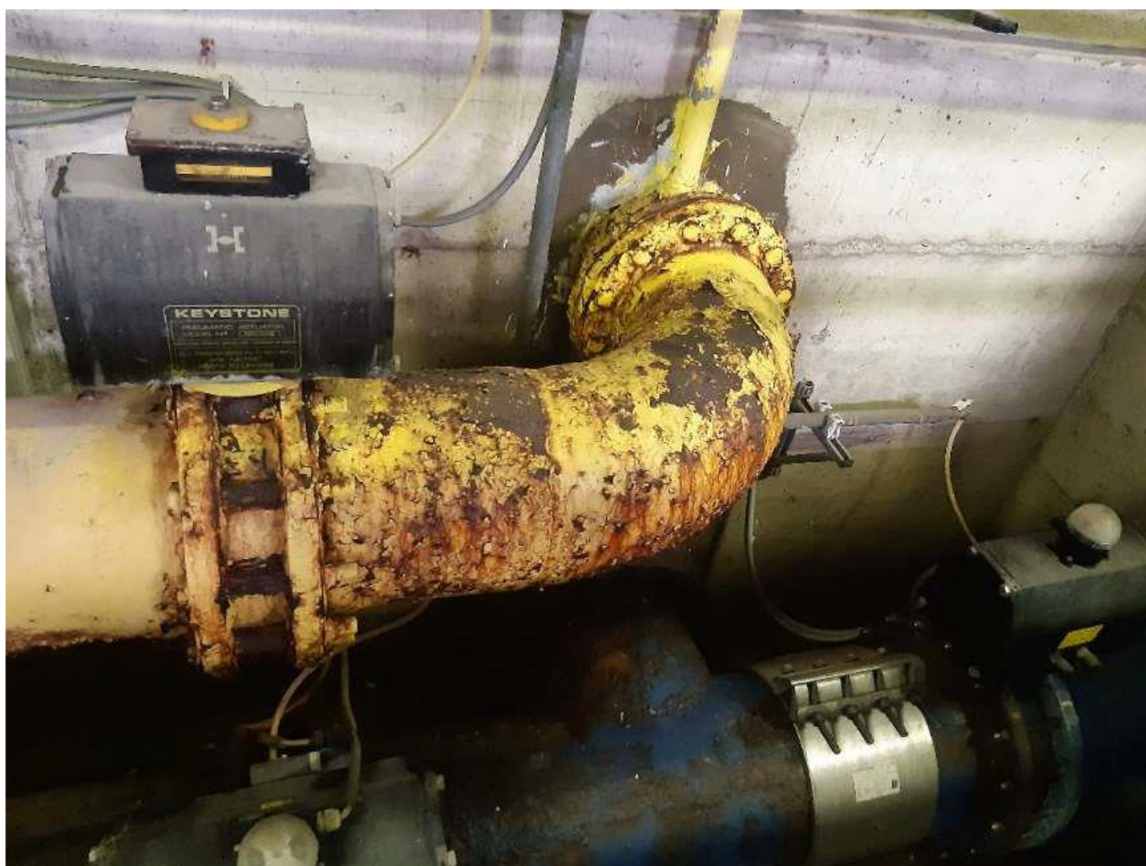
Foto 1 – Particolare linea aria DN 250 con valvola a farfalla e attuatore pneumatico (giallo) e linea acqua DN400 con valvole a farfalla e attuatori pneumatici e giunto di smontaggio (blu)
