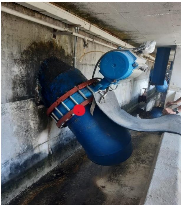
Foto 11 – Tratto terminale scarico torbida DN500 da rimuovere e sostituire – Limite di fornitura (punto rosso)
