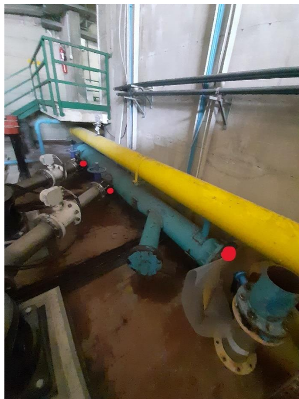
Foto 8 – Limite fornitura tubazione DN400 tratto terminale lato pompe di contro lavaggio (punti rossi)
