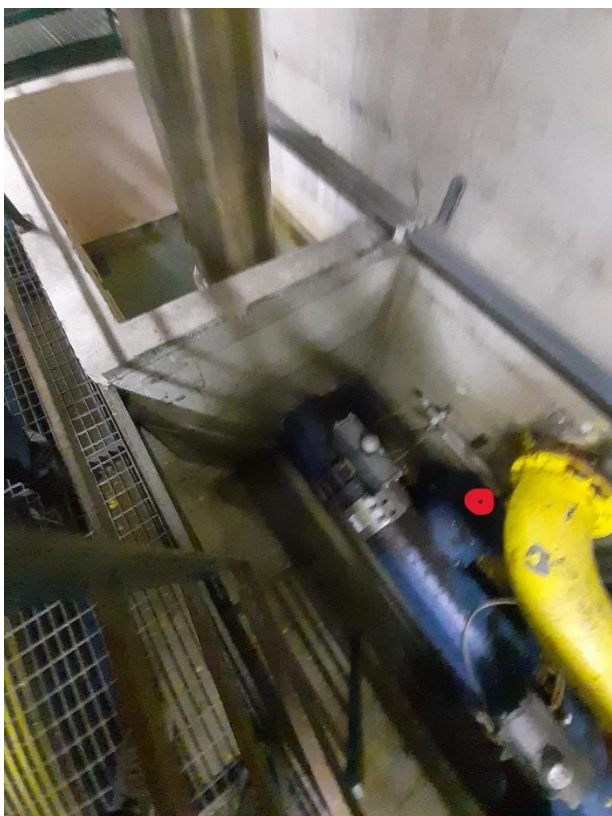
Foto 7 – Flangia collegamento tronchetto inghisato DN400 – Limite fornitura tratto terminale (punto rosso)
