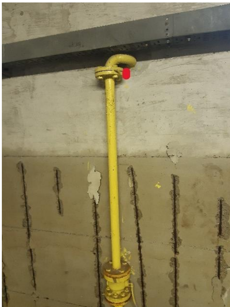
Foto 6 – Tubazione sfiato linea aria DN50 – Limite fornitura (punto rosso)
