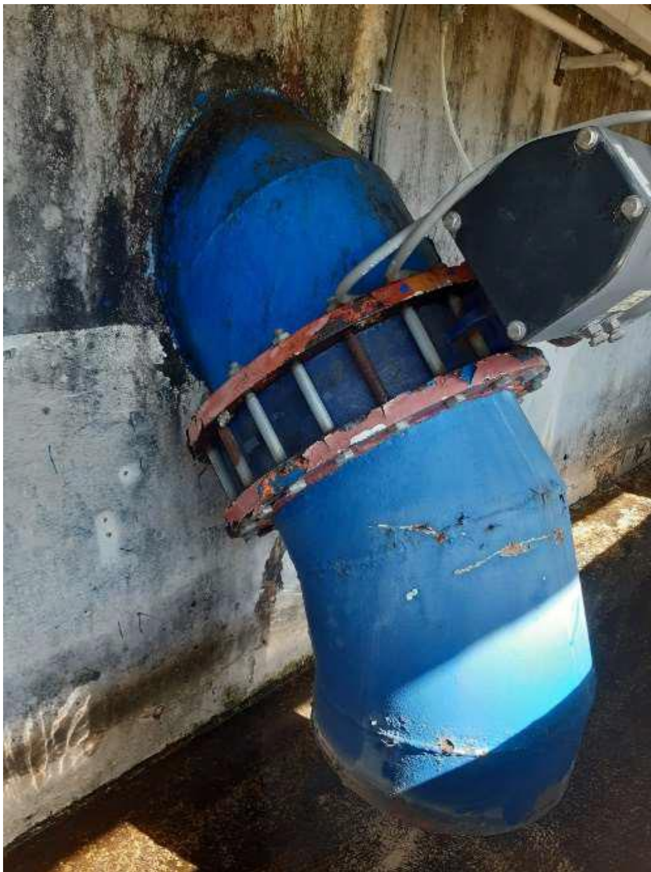
Foto 2 – Particolare linea scarico torbida DN 500 con valvola a farfalla e attuatore pneumatico
